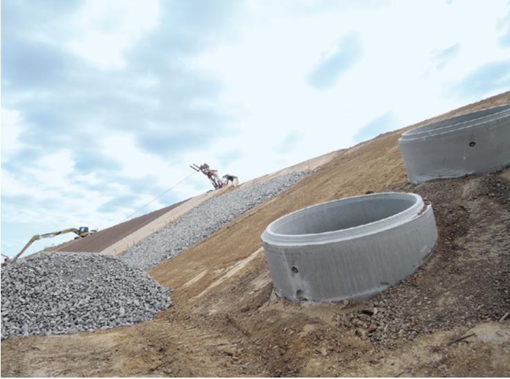
**Abb. 10-22** Bauarbeiten am westlichen Wall, der zentralen Maßnahmenfläche für die Mauereidechse, im Sommer 2015. Erkennbar sind die örtlich einzubauenden, mit Schotter zu füllenden Schachtringe.
