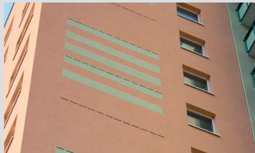
Von verputzten und gestrichenen Einbausteinen sind nur die Einflugöffnungen zu sehen. Sie können auch als Gestaltungselemente genutzt werden (Bild rechts).
