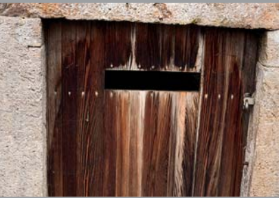
Eine Einflugöffnung (ab ca. 40 x 15 cm) ermöglicht Fledermäusen den Zugang zum Keller.
