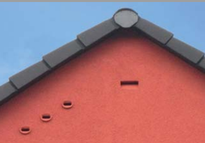
Von verputzten und gestrichenen Einbausteinen sind nur die Einflugöffnungen zu sehen. Sie können auch als Gestaltungselemente genutzt werden (Bild rechts).
