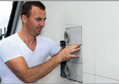
Einbau von Mauerseglerkästen in die Dämmung
