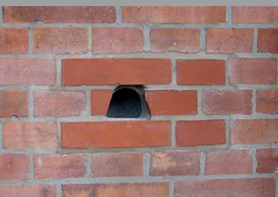
In das Mauerwerk integrierter Einbaustein für Halbhöhlenbrüter
