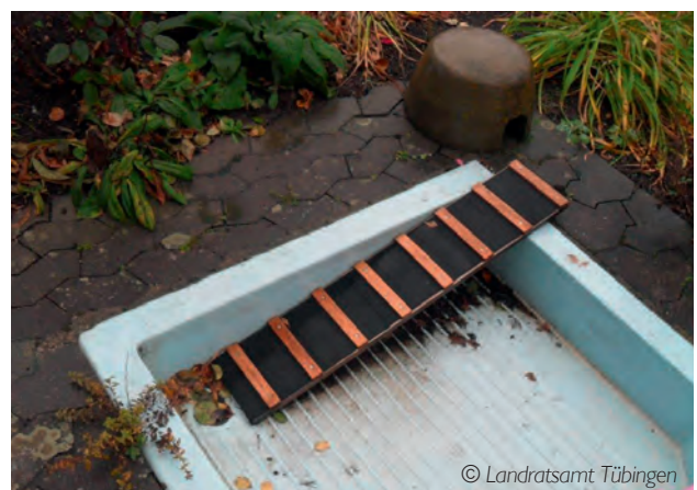
Einfache Entschärfungsmaßnahmen: Engmaschige Vergitterung, erhöhte Ränder oder Ausstiegshilfen
