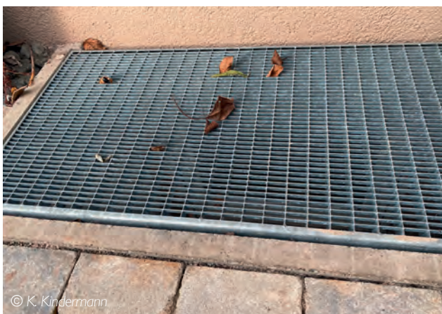
Einfache Entschärfungsmaßnahmen: Engmaschige Vergitterung, erhöhte Ränder oder Ausstiegshilfen
