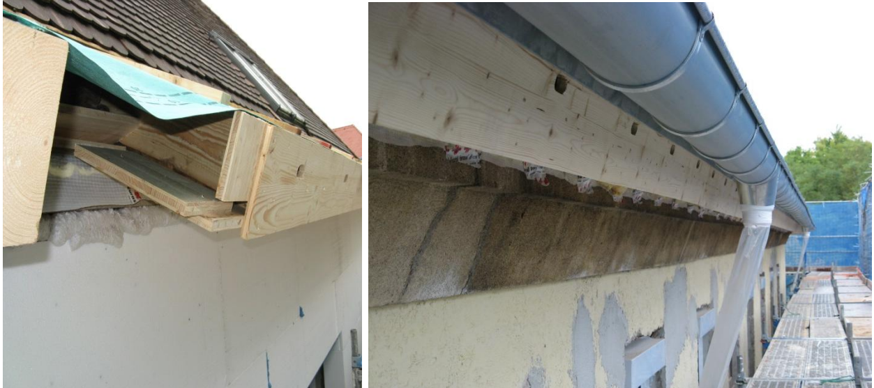
Einbau von Mauersegler-Nisthöhlen bei der Sanierung von Gebäuden im Französischen Viertel in Tübingen (Fotos: A. Hachenberg).
